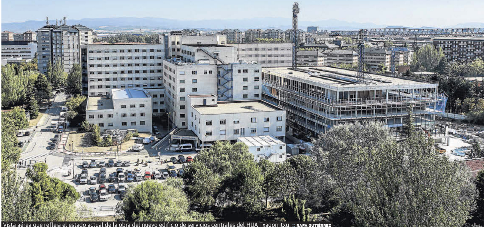
Vista aérea que refleja el estado actual de la obra del nuevo edificio de servicios centrales del HUA Txagorritxu. :: RAFA GUTIÉRREZ
