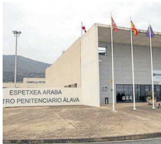
Acceso al centro penitenciario Araba (Zaballa).
